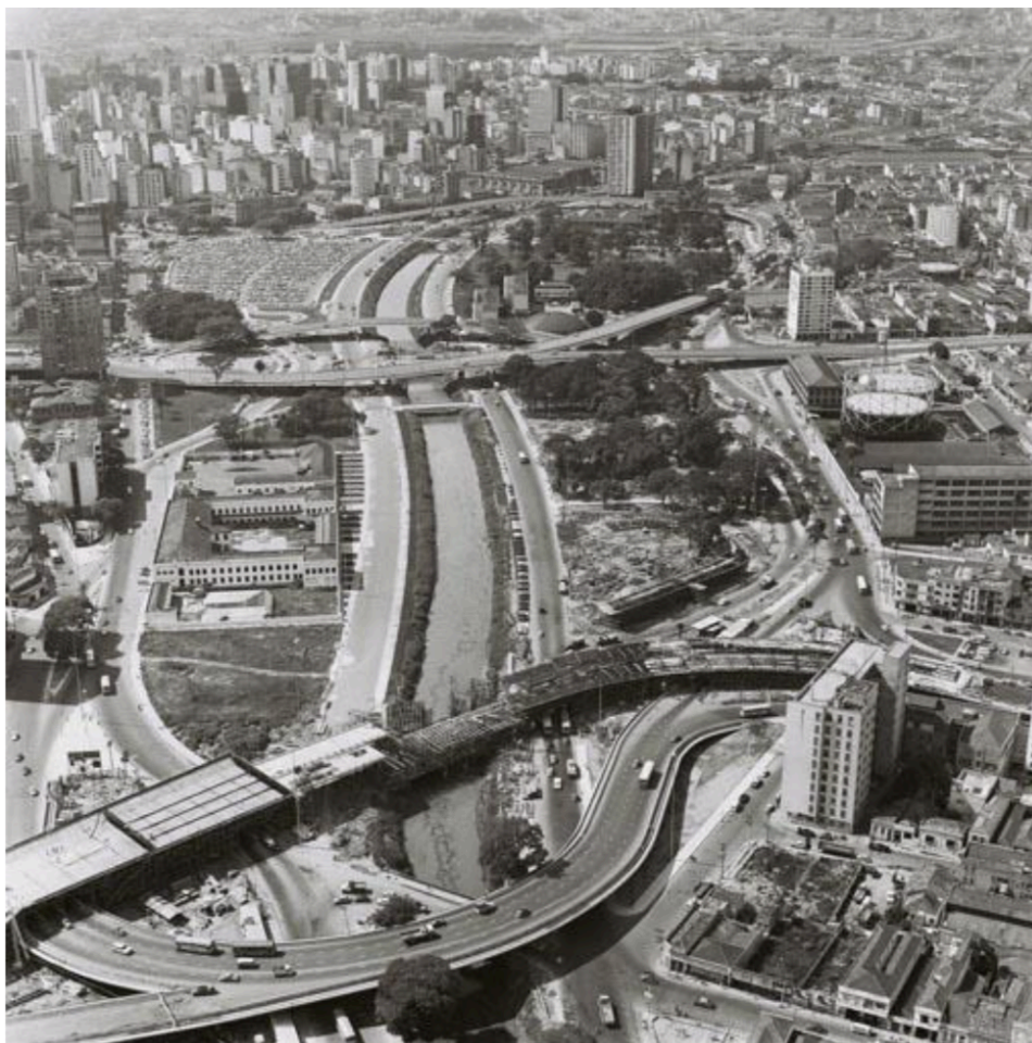
Figura 4 - Obras viárias sobre o Parque D. Pedro II, 1971
