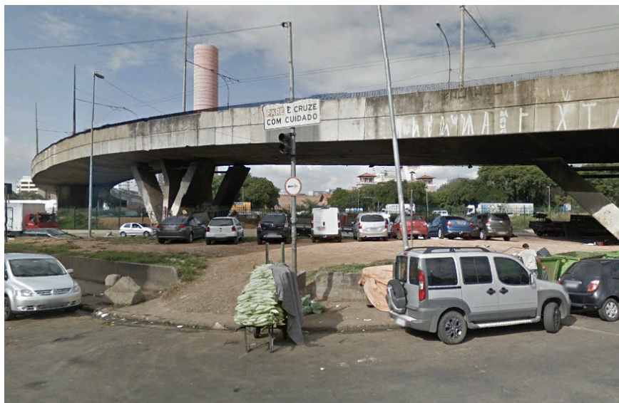
Figura 16 - Área residual abaixo do Viaduto Diário Popular
