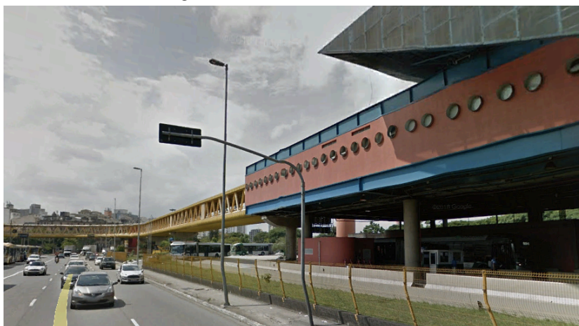
Figura 12 - Passarela de acesso
